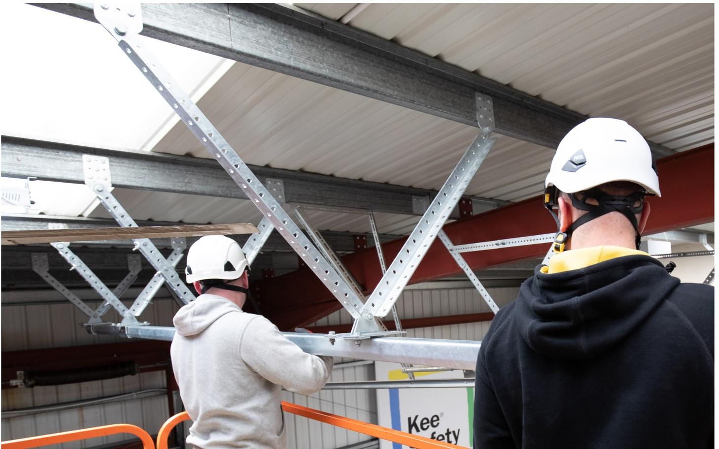
Deux installateurs utilisant une plateforme élévatrice fixent le rail à l'infrastructure du toit.
